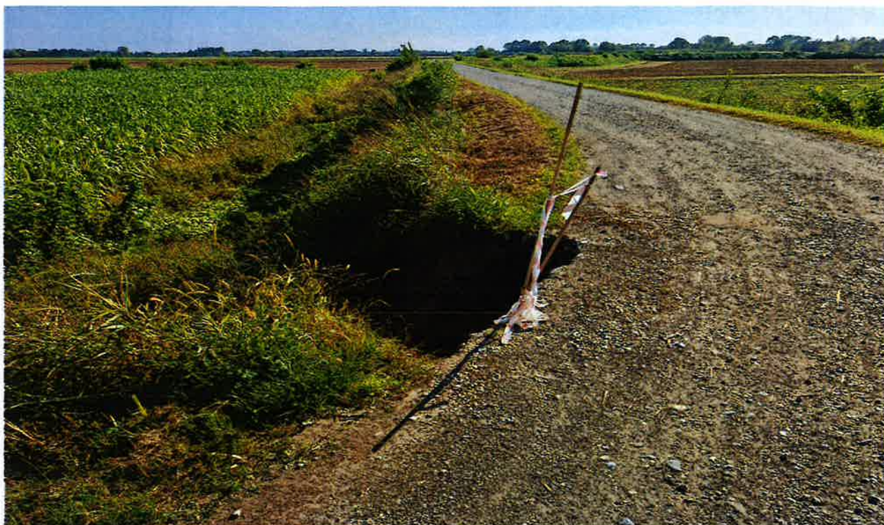
Sviluppo a collasso per cavernamenti i profondità nel corpo arginale sx Fiume Chiese.
