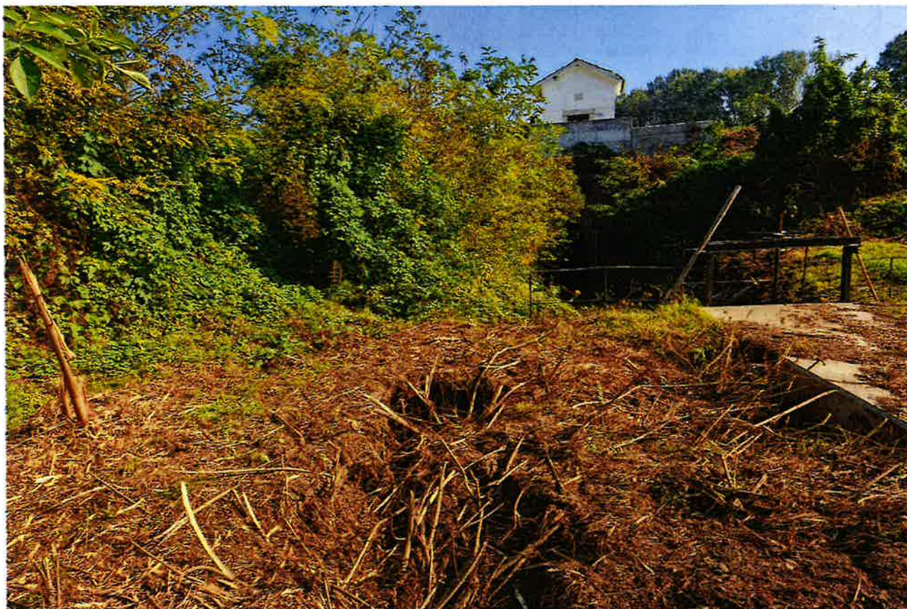
Franamento a seguito di cavernamenti al piede d'argine. Località Chiavica Regona -Bizzolano
