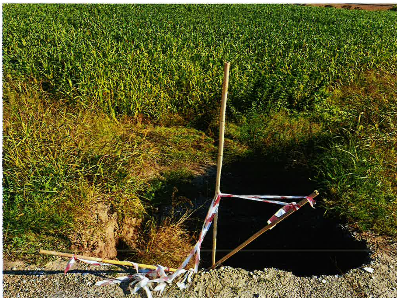
Sviluppo a collasso per cavernamenti i profondità nel corpo arginale sx Fiume Chiese.
